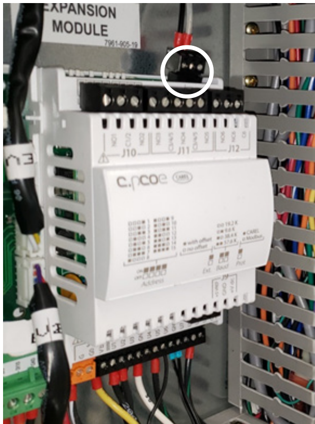
FIGURA 88 Desenchufe Modbus del módulo de expansión
