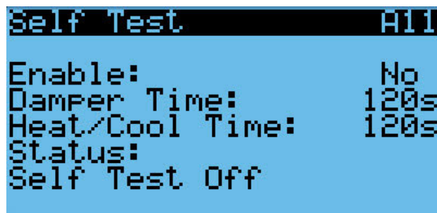
FIGURA 10 Ejecución de una autoprueba
