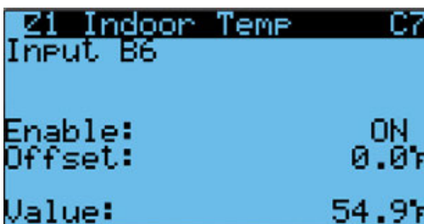
FIGURA 39 Habilitar/inhabilitar sensor de temperatura interior de zona 1
