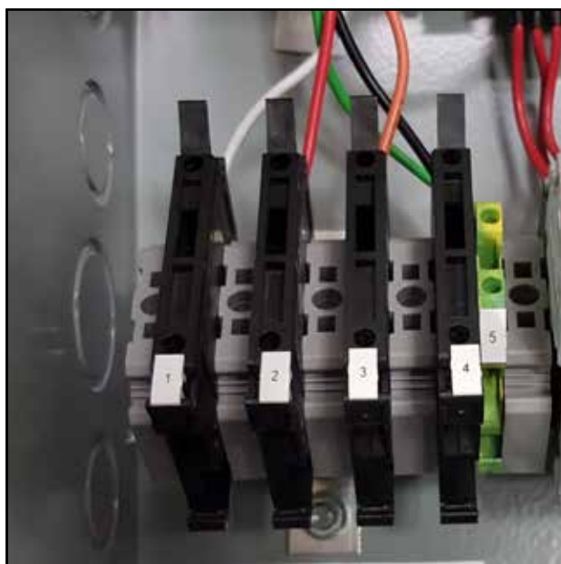
FIGURE 1.2 Bornes d'alimentation du LC6000 protégées par fusible
