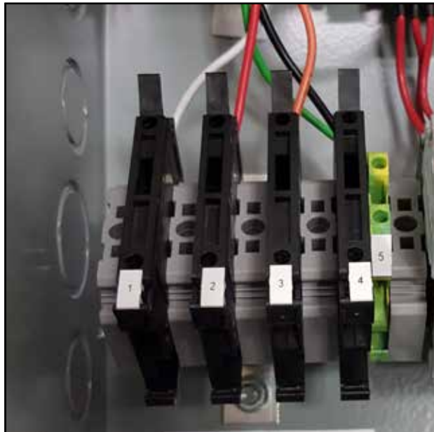
FIGURA 1.2 Terminales de fuente de alimentación con fusibles del LC6000
